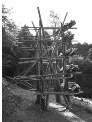
写真一 完成した櫓
