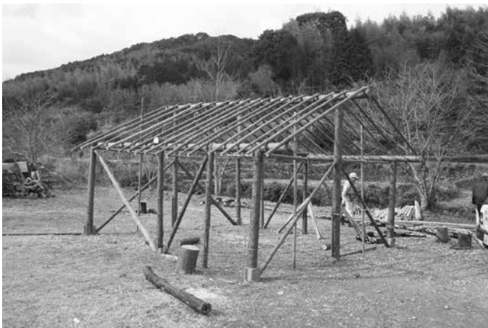
写真一 小屋づくり
